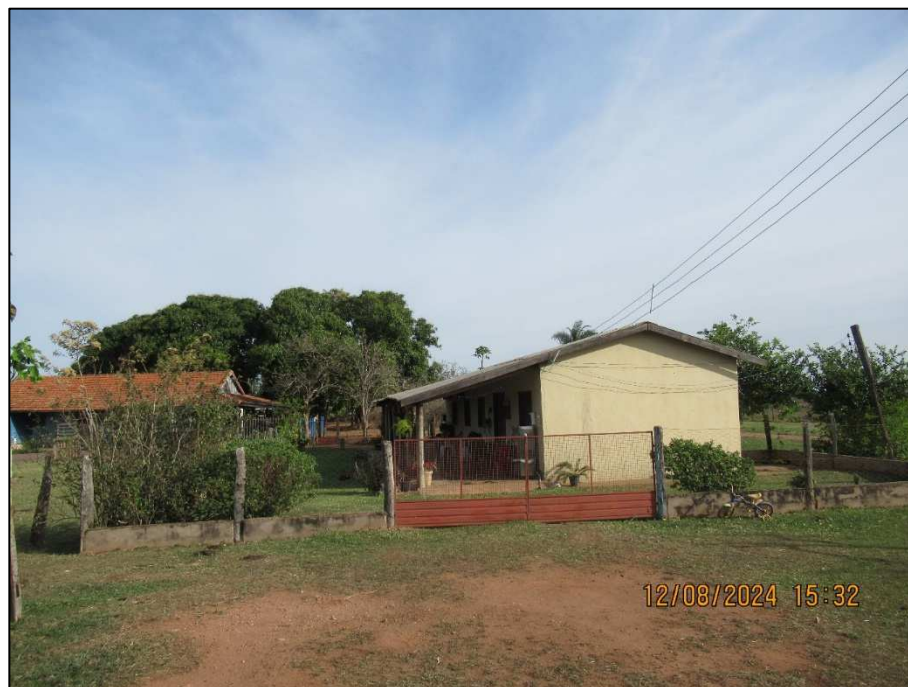
Figura 23. Vista lateral da residência vista na Figura 22.
