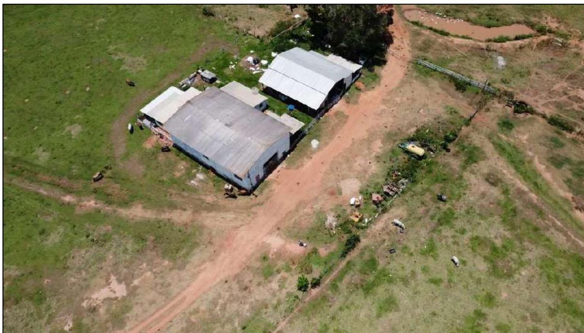
Figura 21. Vista aérea da área da sede: armazém e depósito.
